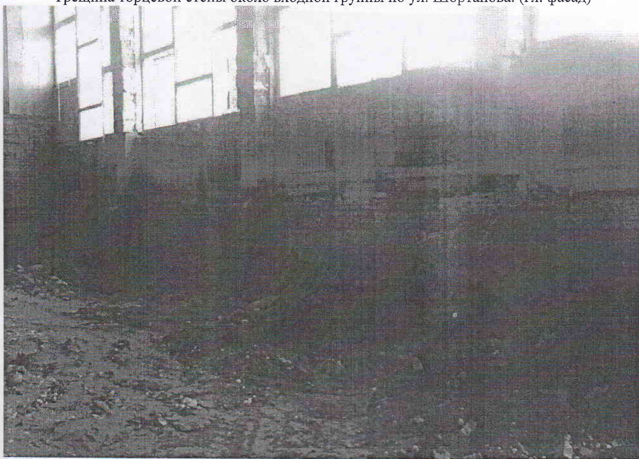
Общий вид наружной стены вдоль проезда. Уширения под металлические колонны выше отметки подошвы фундамента
